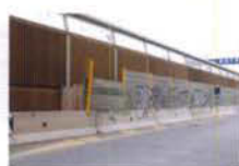
Cantiere AV, via Carracci.
